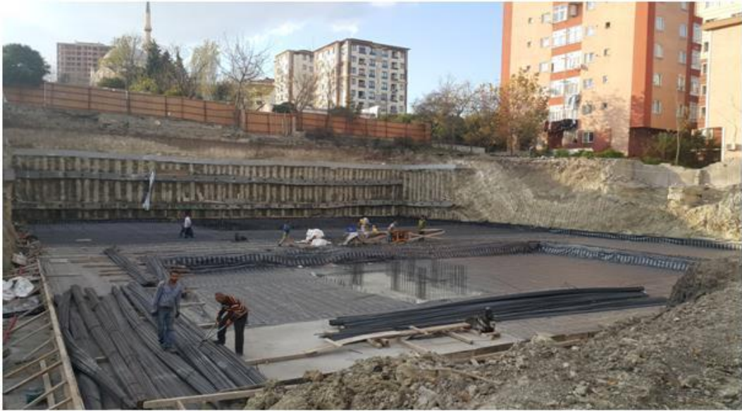
Şekil 25: Ercan Sitesi Kentsel Dönüşüm Yıkım Projesi Sonrası Yapım Çalışmaları
