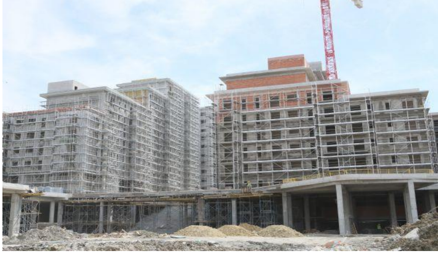
Şekil 6: Eski Cezaevi Kentsel Dönüşüm Projesi İnşaat Alanı
