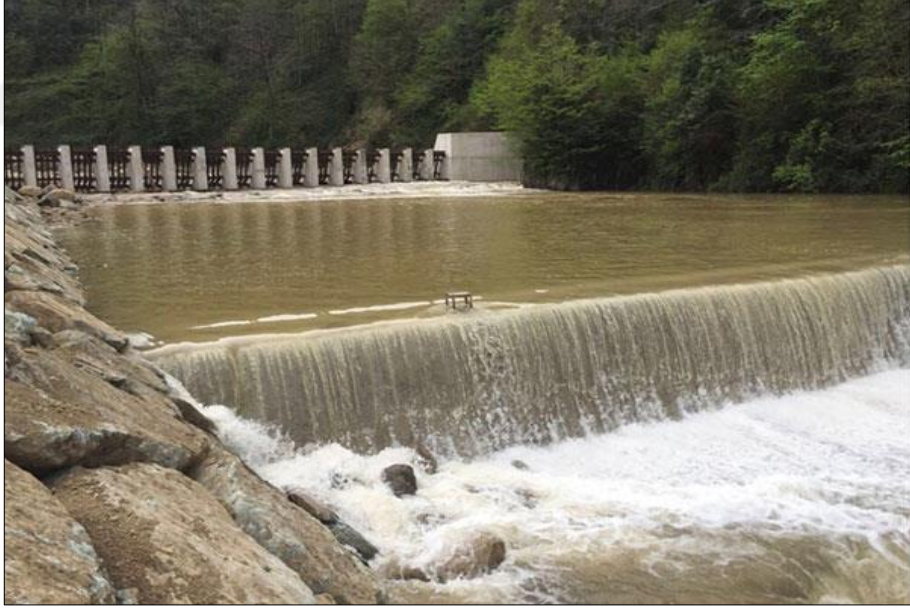
Şekil 1.12. Rize’de yapımı devam eden Türkiye’nin ilk geçirgen “tersip bendi” özelliğini taşıyan “Merkez ve Güneysu İlçeleri Taşlıdere Vadisi Islahı Beşinci Kısım” projesinde yüzde 80 fiziki gerçekleşmeye ulaşıldığı bildirildi (2017)
