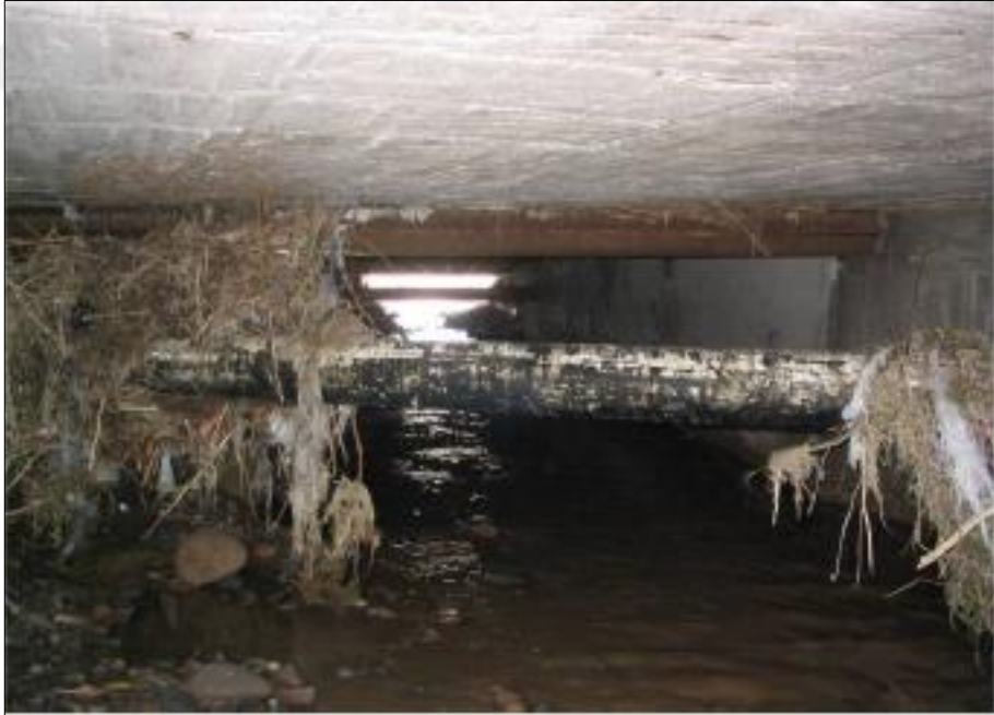
Şekil 1.14. Dere Yatağı Kesitinin Daraltılması
