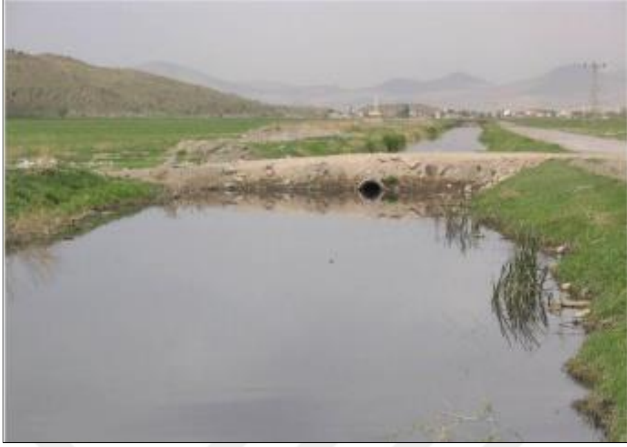
Şekil 1.15. Dere Yatağının Kapatılması
