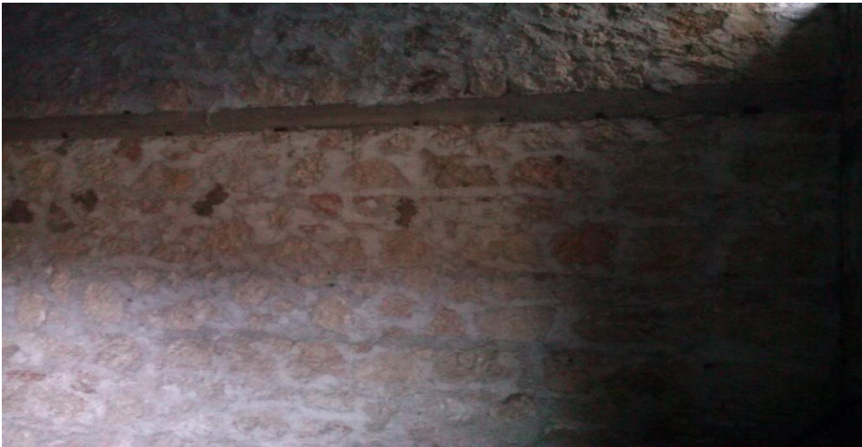
Şekil 4.11. Un fabrikasındaki hangarlarda taze dışkı izi olmayan duvarlar
