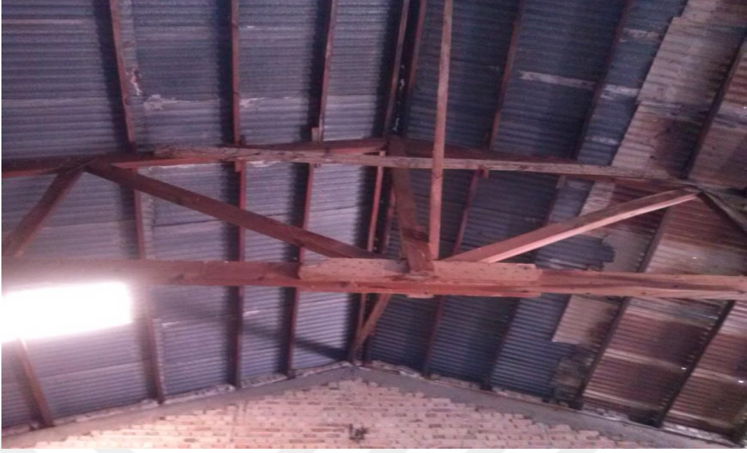
Şekil 4.5. Un fabrikasındaki bir hangarın çatısı
