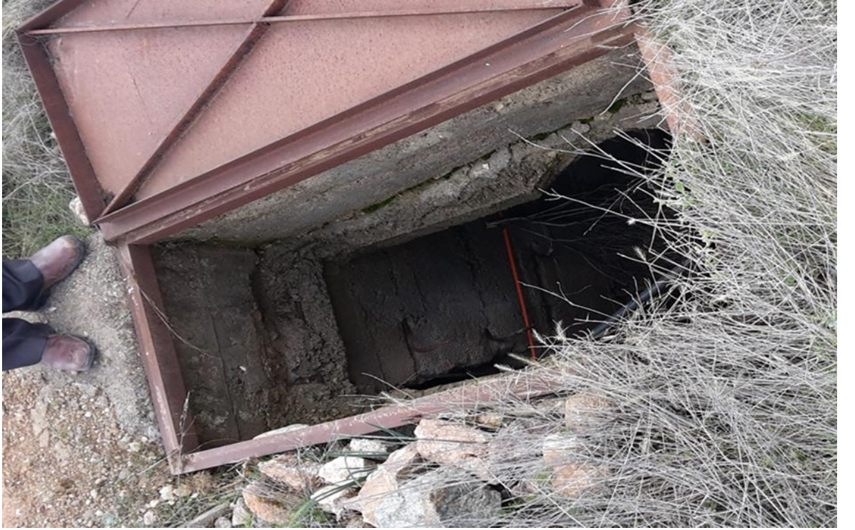
Şekil 3.6. Tünek 1'in demir kapı ile kapatılmış ana giriş kapısı
