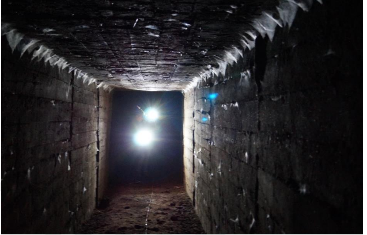
Şekil 4.16. Keskin ilçesindeki kapalı kanalda bulunan Tegenaria faniapollinis türünün ağları
