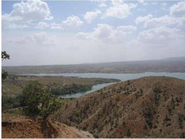
Şekil 1.3. Kapulukaya Barajı (Kırıkkale, Karaahmetli)
