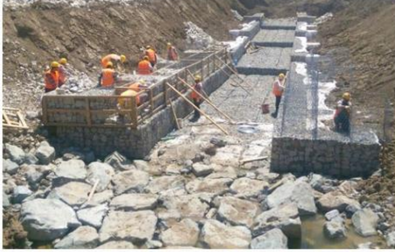
Şekil 3.7. Trans Anadolu Doğalgaz Boru Hattı Projesi (TANAP) Kapsamında Yer Alan Nehir Islahı İşinde Gabion Sepet Uygulaması (Maccaferri)
