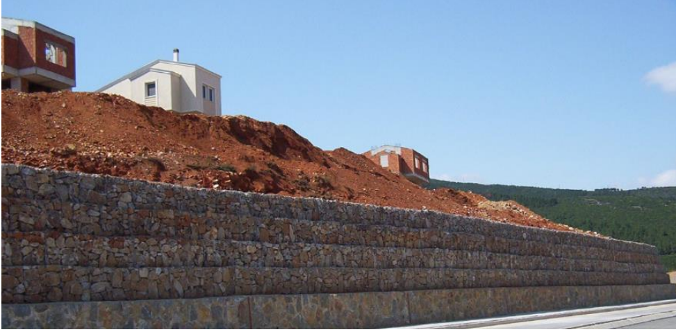
Şekil 3.8. Balıkesir Bandırma Eti Bor Tesisleri Gabion Sepet Uygulaması (Geoart)
