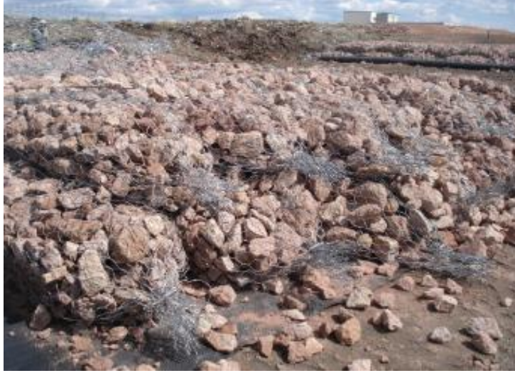
Şekil 3.11. Örnek Gabion Torba Uygulaması (Divan tel örgü)
