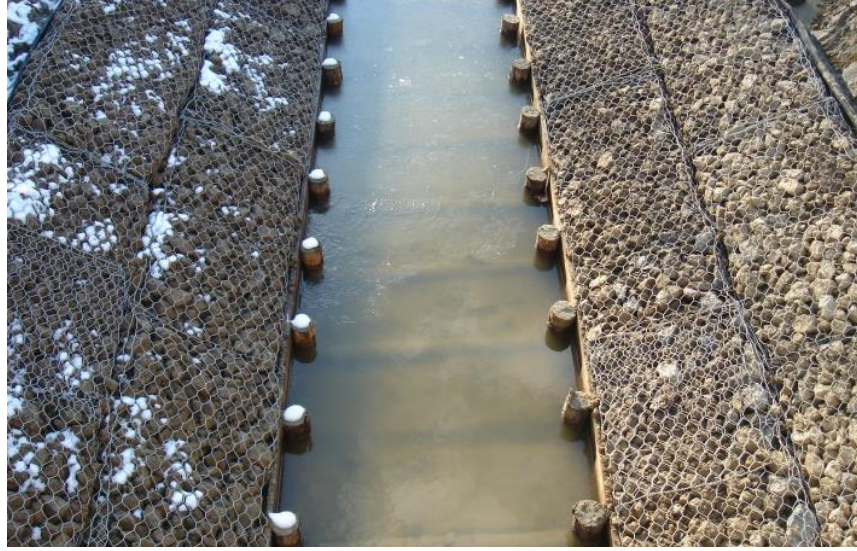
Şekil 3.9. Örnek Şilte Gabion Uygulaması (Kıcımın)
