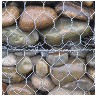
Şekil 3.3. Altıgen Tel Örgülü Örnek Gabion Duvar (Shengxin)
