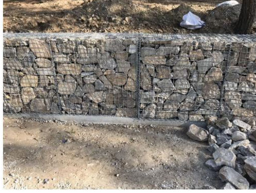
Şekil 3.1. Örnek Gabion Sepet Uygulaması (Atık tel)
