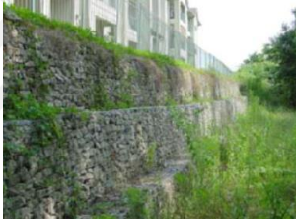
Şekil 3.6. Gabion Duvarların Yeşillendirilmesi (Kanter, 2014)
