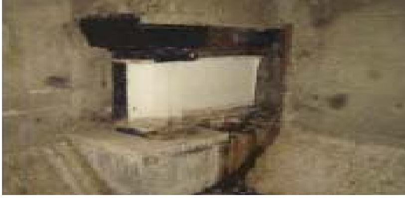
Şekil 4. Orta açıklık genişleme derzindeki mafsal düzeneği
