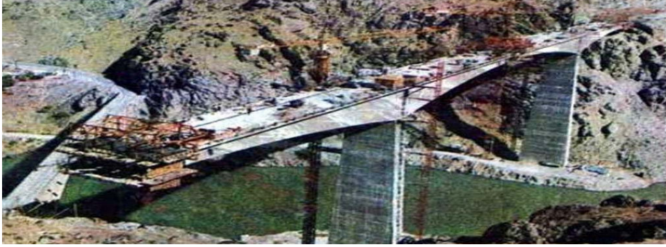
Şekil 2. Kömürhan Köprüsü'nün dengeli konsol yöntemi ile yapımı
