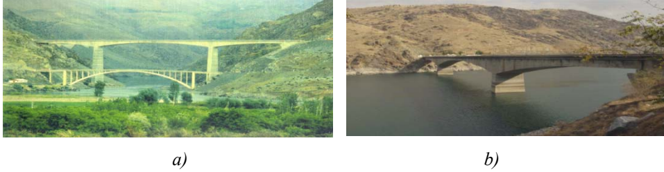
Őekil 1. a) Eski ve yeni (baraj yapılmadan önce) b)Yeni Kömürhan Köprüsü
