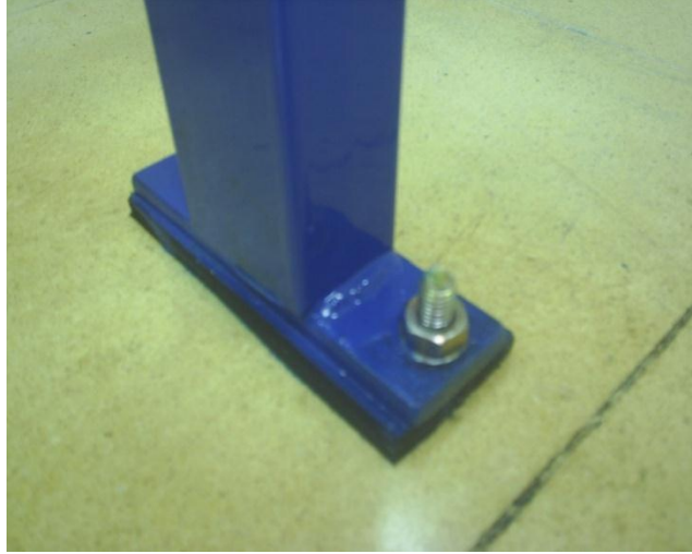
Şekil 3.2. Konstrüksiyonun zemine montajı
