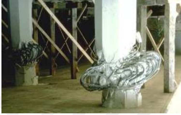
Şekil 1.1. Imperial Valley Depremi (1979) sırasında kolonlarda oluşan basınç kırılmasına örnek
