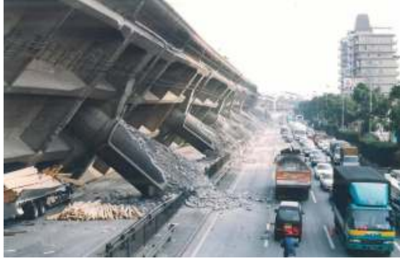
Şekil 1.2. Kobe Depremi (1996)’nde oluşan devrilme etkisine örnek
