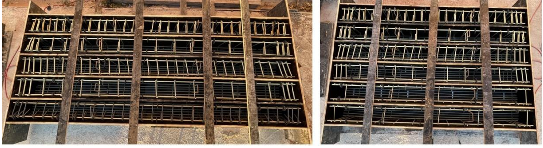
Şekil 8. Donatı yerleşmiş kalıp resmi
