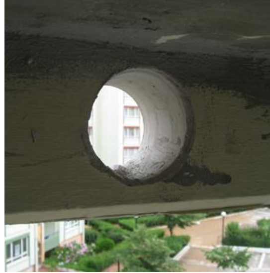
Şekil 1.1. Betonarme kirişlerde gövde boşluğu
