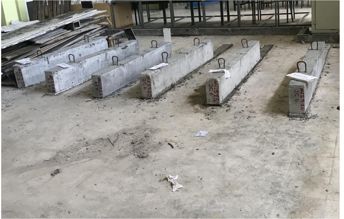
Şekil 2.8. Normal Dayanımlı Beton Dökümü Sonrası Kirişlerin Görünüşleri
