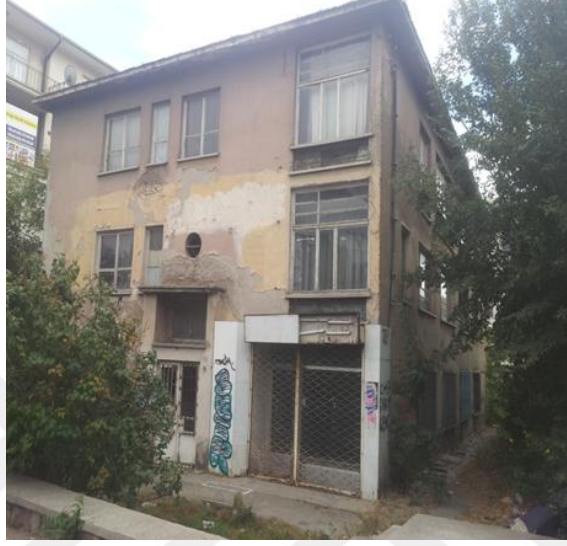
Şekil 2.6. Bahriye Üçok Caddesi No:11 Ön Cephe Genel Görünüş
