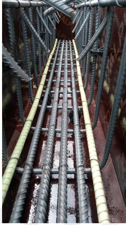
Şekil EK-4.27. G2S4 elemanı beton dökümü öncesi
