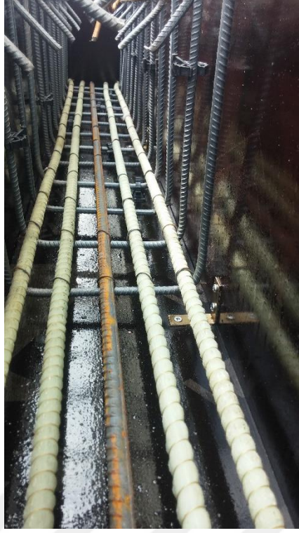
Şekil EK-4.19. G4S1 elemanı beton dökümü öncesi
