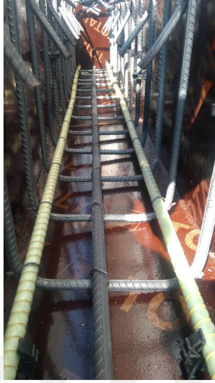
Şekil EK-4.47. G2S1 elemanı beton dökümü öncesi
