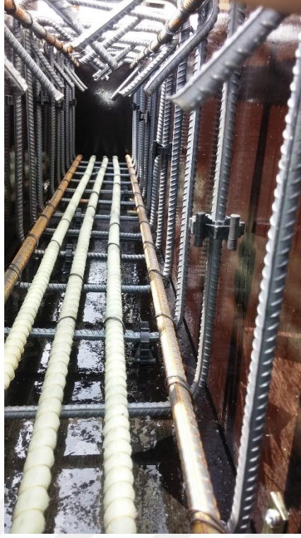
Şekil EK-4.17. G3S2 elemanı beton dökümü öncesi
