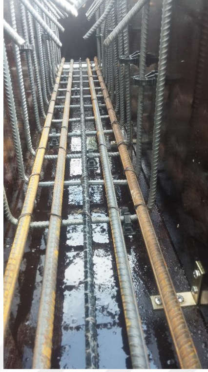
Şekil EK-4.3. B1S4 elemanı beton dökümü öncesi
