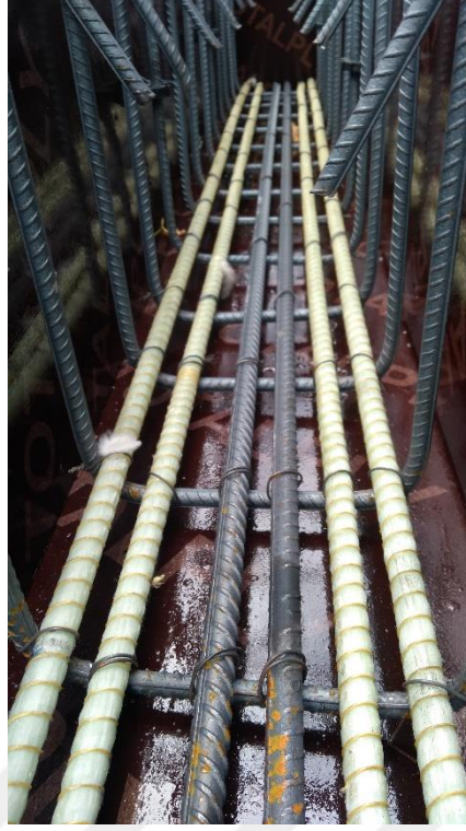
Şekil EK-4.31. G4S2 elemanı beton dökümü öncesi
