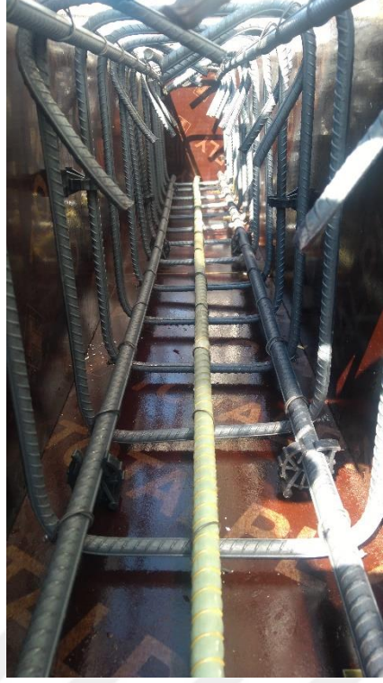
Şekil EK-4.45. G1S2 elemanı beton dökümü öncesi
