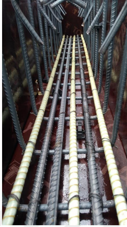
Şekil EK-4.29. G3S3 elemanı beton dökümü öncesi
