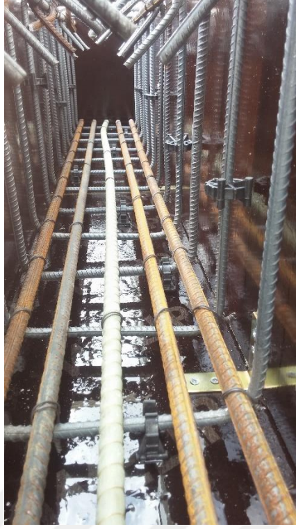
Şekil EK-4.13. G1S4 elemanı beton dökümü öncesi
