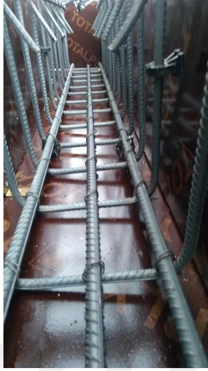
Şekil EK-4.37. Salt çelik donatılı S3 Referans elemanı beton dökümü öncesi
