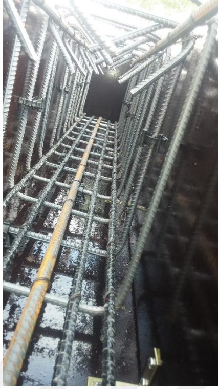
Şekil EK-4.9. B4S1 elemanı beton dökümü öncesi
