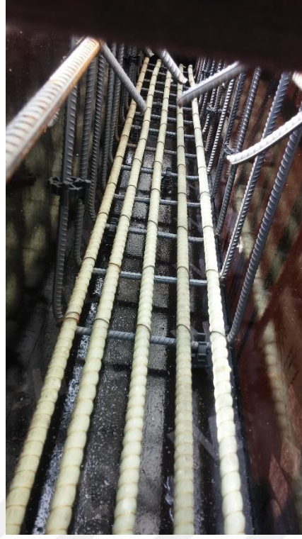
Şekil EK-4.21. G5 Referans elemanı beton dökümü öncesi
