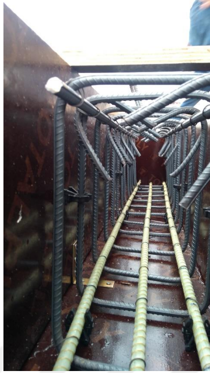
Şekil EK-4.49. G3 Referans elemanı beton dökümü öncesi
