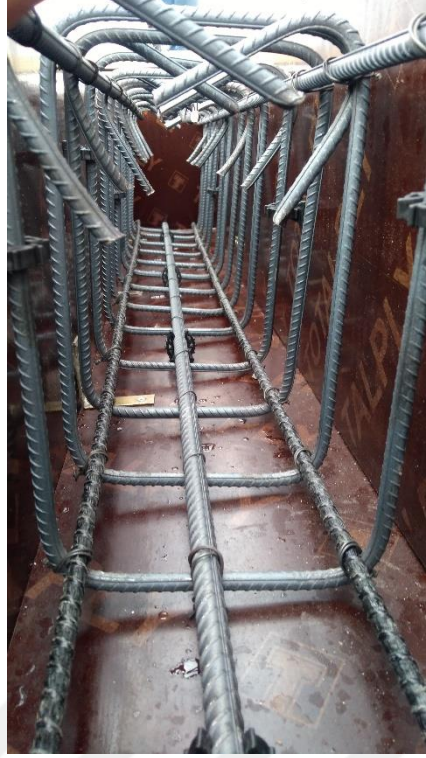
Şekil EK-4.41. B2S1 elemanı beton dökümü öncesi
