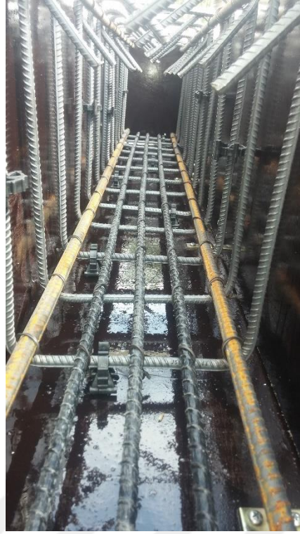
Şekil EK-4.7. B3S2 elemanı beton dökümü öncesi
