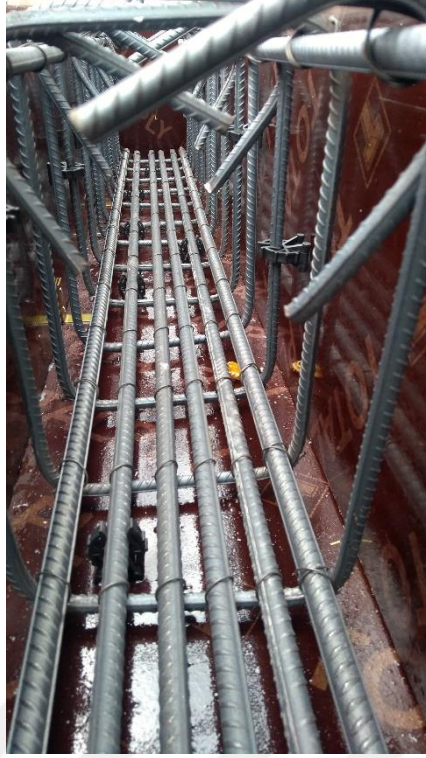
Şekil EK-4.23. Salt çelik donatılı S6 Referans elemanı beton dökümü öncesi
