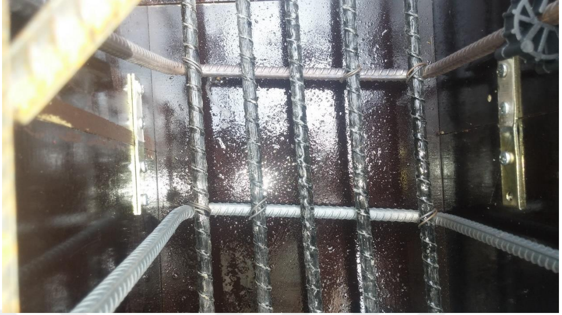
Şekil EK-4.11. B5 Referans elemanı beton dökümü öncesi
