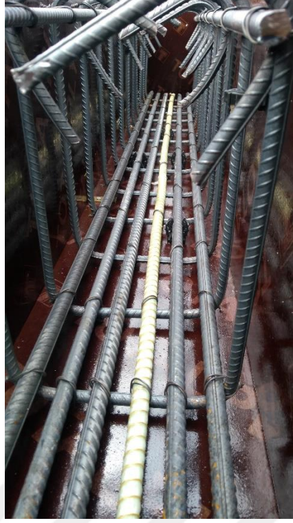
Şekil EK-4.25. G1S5 elemanı beton dökümü öncesi
