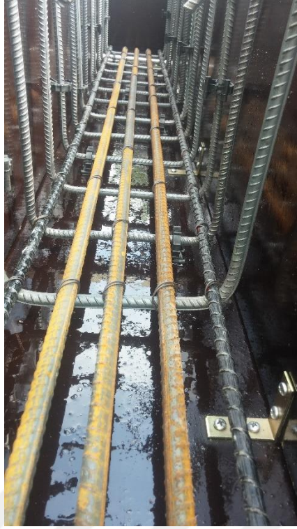
Şekil EK-4.5. B2S3 elemanı beton dökümü öncesi
