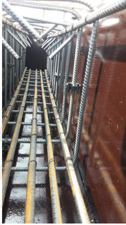
Şekil EK-4.1. Salt çelik donatılı S5 Referans elemanı beton dökümü öncesi
