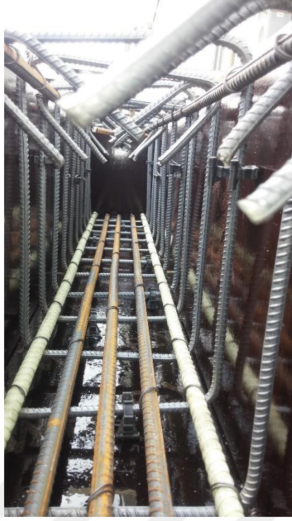
Şekil EK-4.15. G2S3 elemanı beton dökümü öncesi
