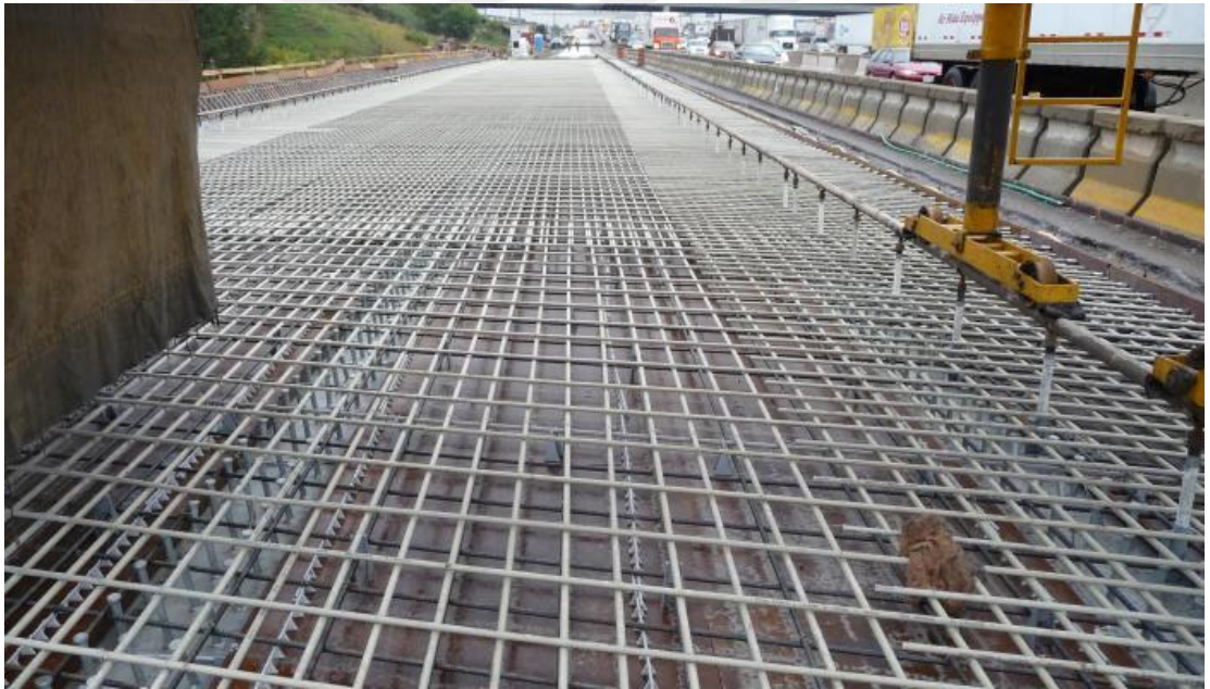
Şekil 1.4. FRP donatılı bir köprü tabliyesi
