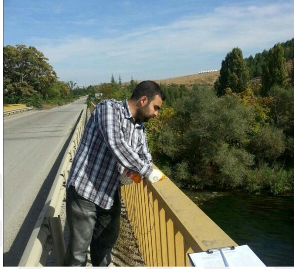
Şekil 3.6. Köprü üzerinden yapılan ölçüm (1)
