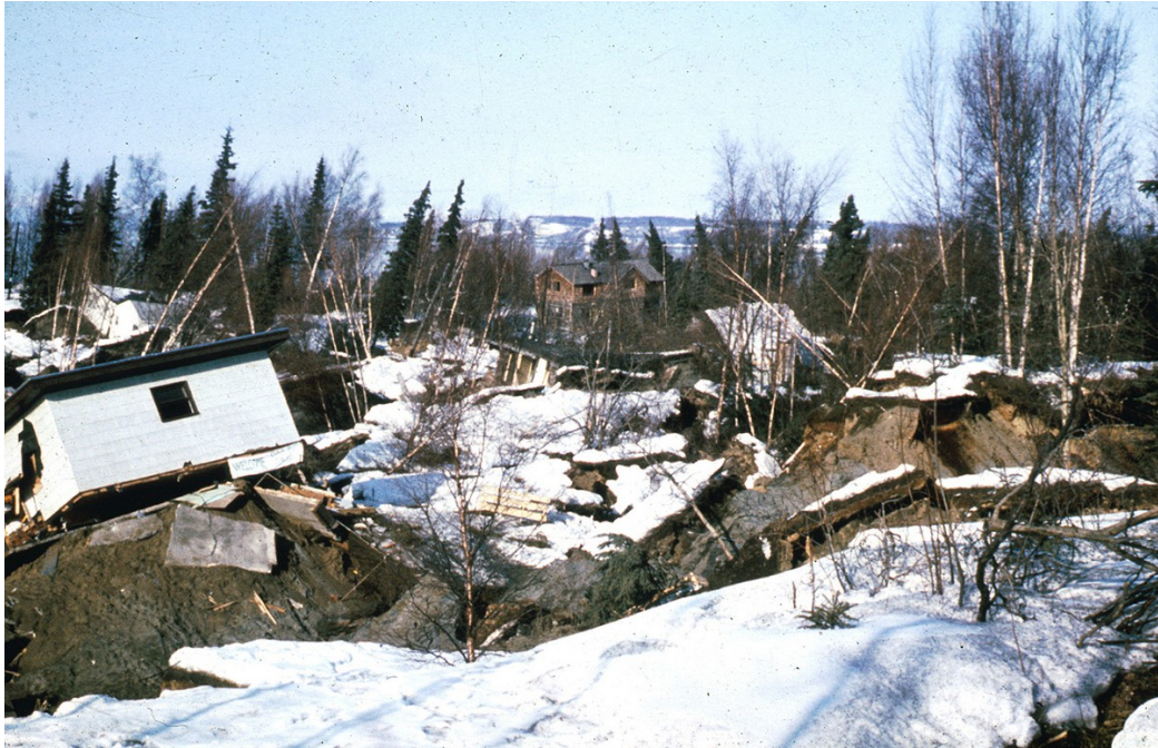
Şekil 1.1 Alaska (1964) depreminde oluşan ağır hasar[12]
