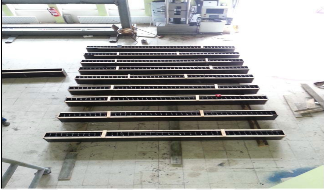
Şekil 2.8. Yüksek dayanımlı kirişlerin beton döküm öncesi kalıp durumu
