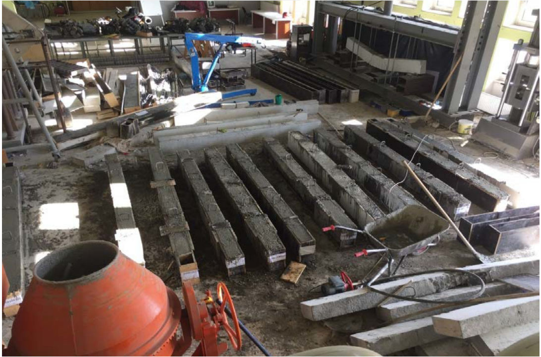
Şekil 2.9. Yüksek dayanımlı kirişlerin beton döküm sonrası kalıp durumu
