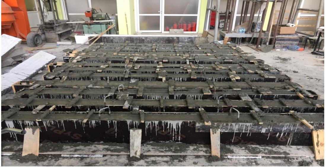
Şekil 2.11. Normal dayanımlı kirişlerin beton döküm sonrası kalıp durumu
