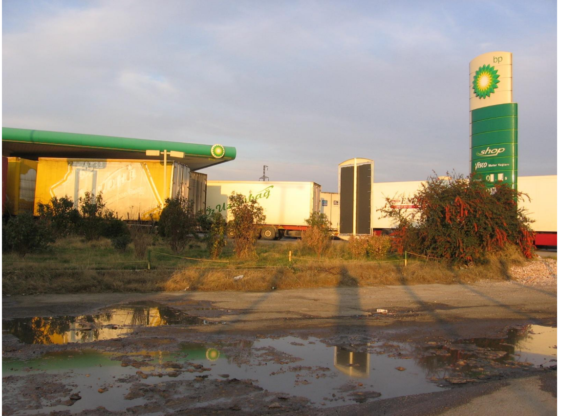
Resim 13-14. Kapıkule Sınır Kapısı – Modernizasyon Öncesi
