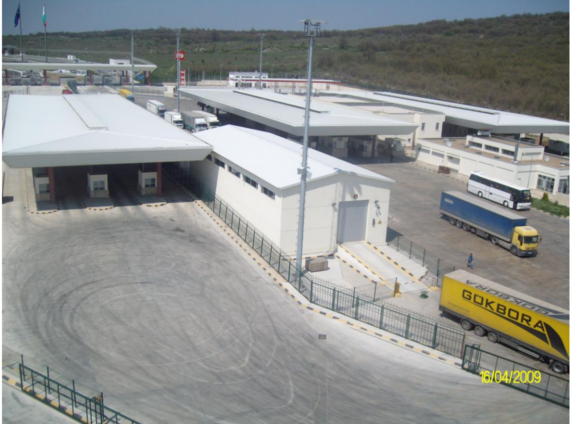
Resim 19-20. Hamzabeyli Sınır Kapısı – Modernizasyon Sonrası
