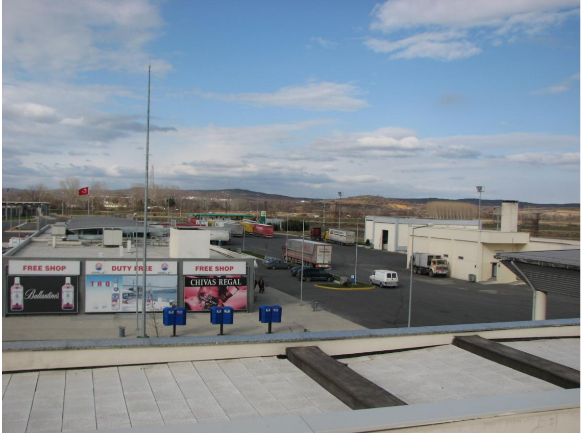
Resim 23-24. İpsala Sınır Kapısı – Modernizasyon Sonrası
