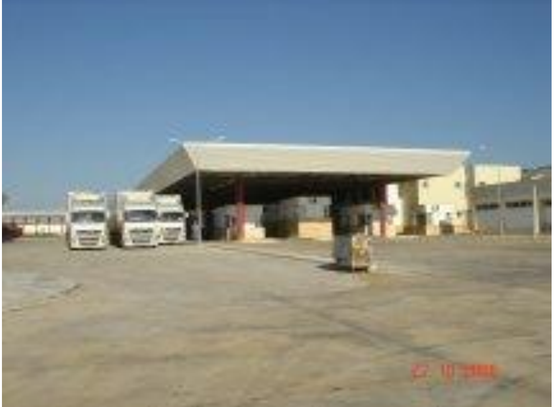
Resim 17-18. Hamzabeyli Sınır Kapısı – Modernizasyon Öncesi
