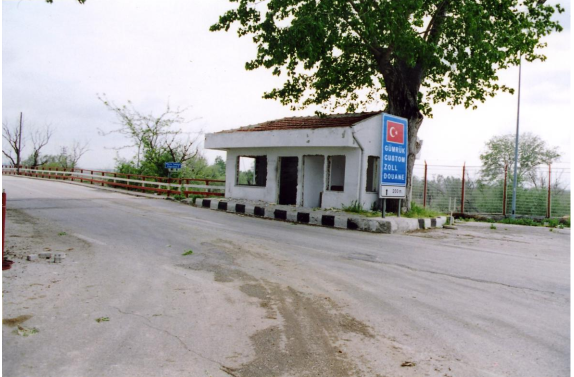
Resim 21-22.İpsala Sınır Kapısı – Modernizasyon Öncesi
