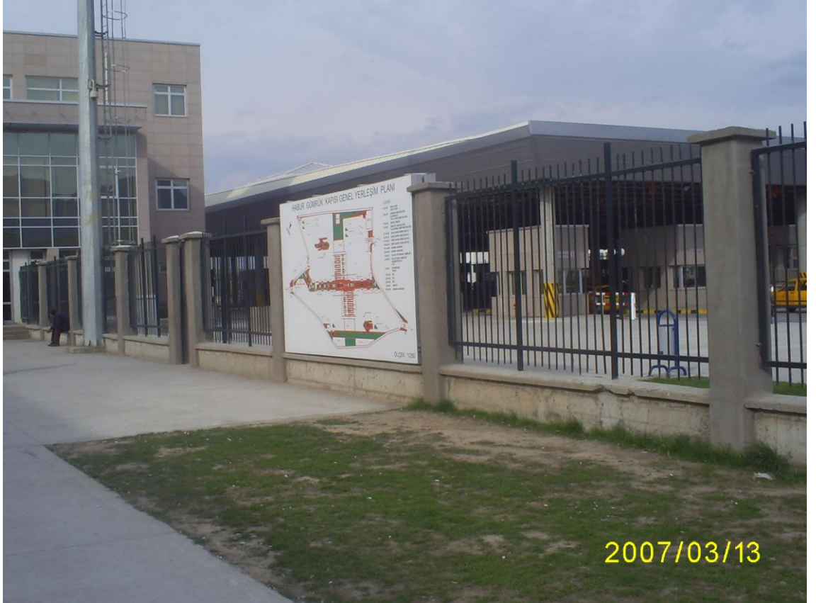
Resim 11-12. Habur Sınır Kapısı – Modernizasyon Sonrası
