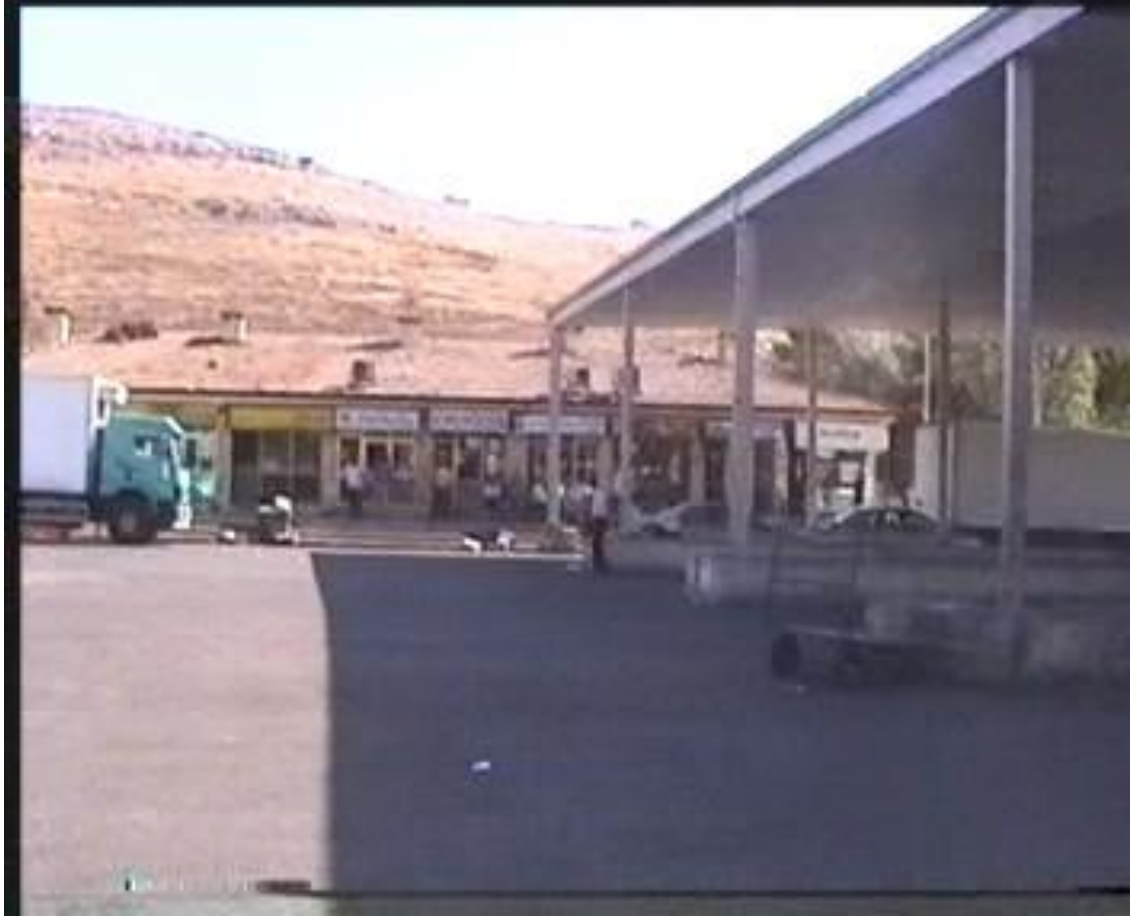
Resim 5-6. Cilvegözü Sınır Kapısı – Modernizasyon Öncesi
