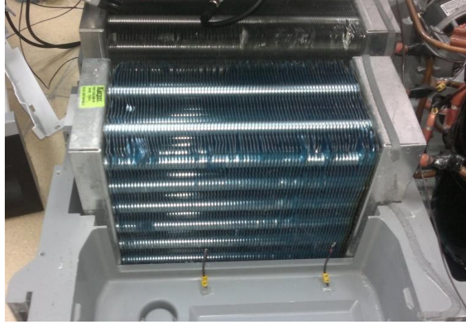
Şekil 3.8. Hava hattında buharlaştırıcı girişinde yer alan iki adet termoeleman
