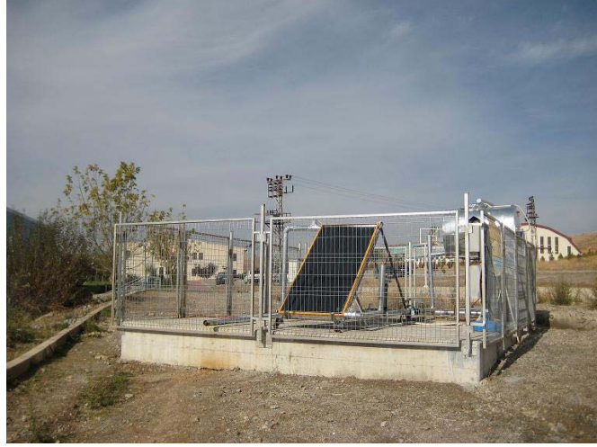
Şekil 7.3.b. Deney tesisatı arazi yerleşimi
