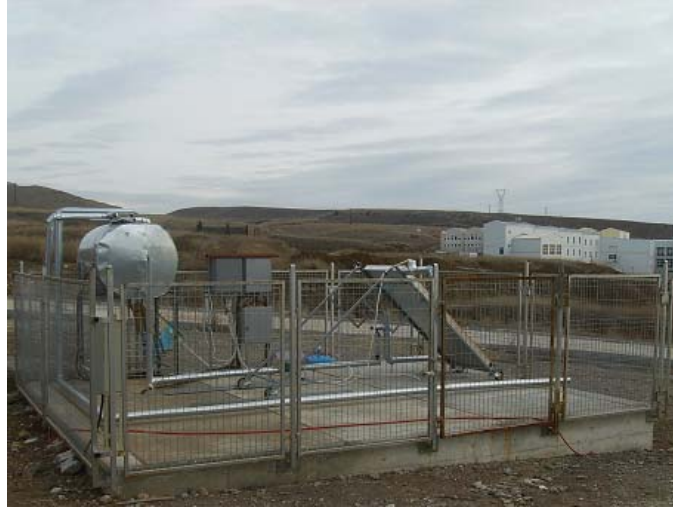
Şekil 7.3.c. Deney tesisatı sol yan görünüşü
