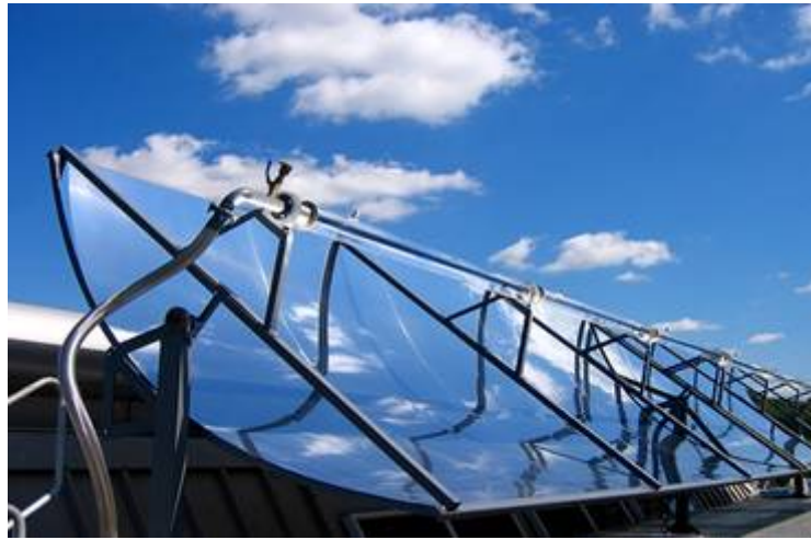
Şekil 2.3. Çizgisel odaklı güneş kollektörü
