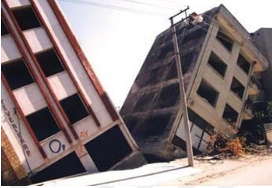
Şekil 5.9. Dar Cepheli Bir Binanın Devrilmiş Hali
