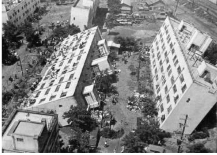
Şekil 5.18. Depremde Sıvılaşma Sebebiyle Devrildiği İddia Edilen Bina
