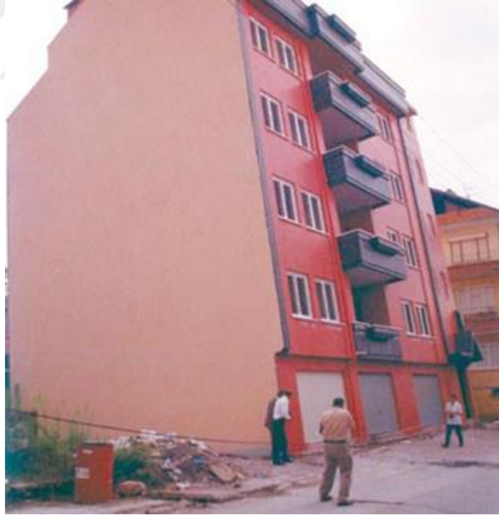
Şekil 5.14. Dar Cepheli Bir Binanın Devrilmeye Yakın Davranışı
