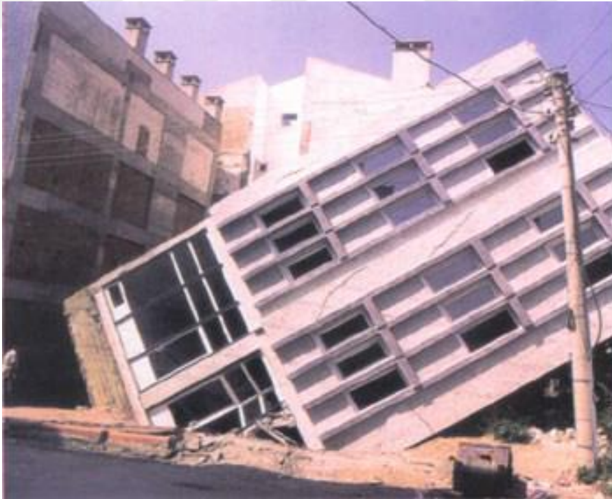
Şekil 5.12. Dar Cepheli Bir Binanın Devrilmiş Hali
