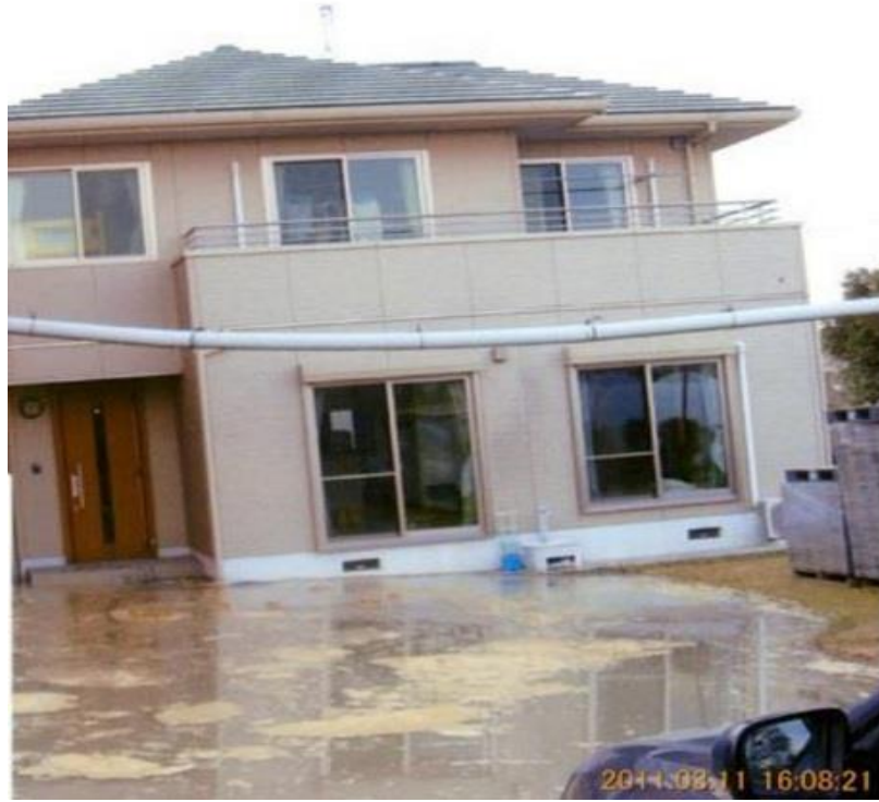
Şekil 5.15. Depremde Sıvılaşan Zeminden Yukarı Çıkan Su Ve Oturan Bina
