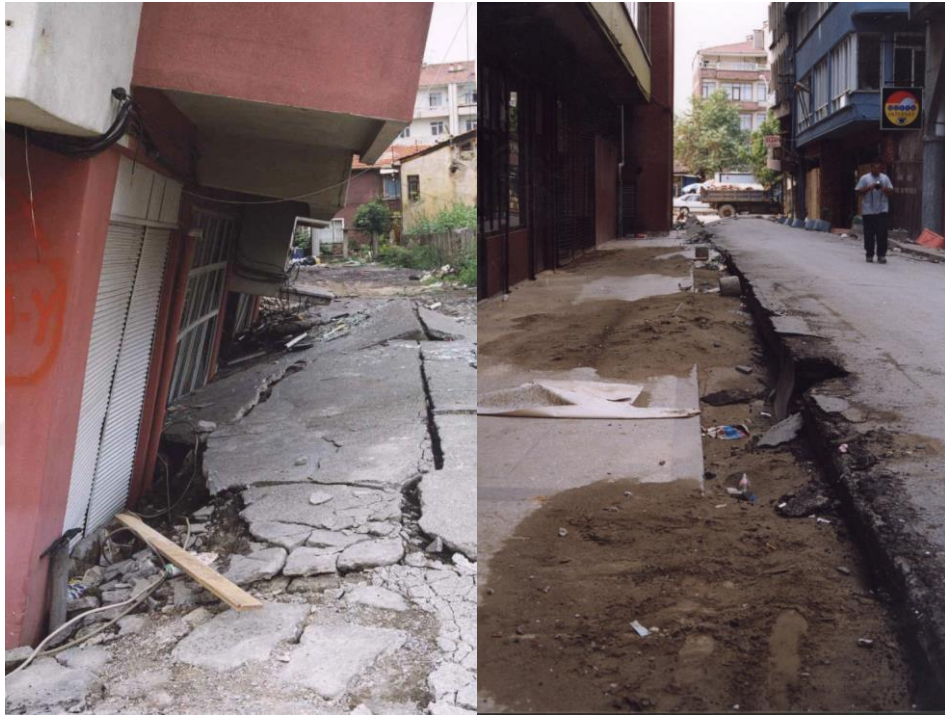
Şekil 5.4. Oturma Formunda Temel Deplasmanları-Tığcılar Mahallesi Adapazarı
