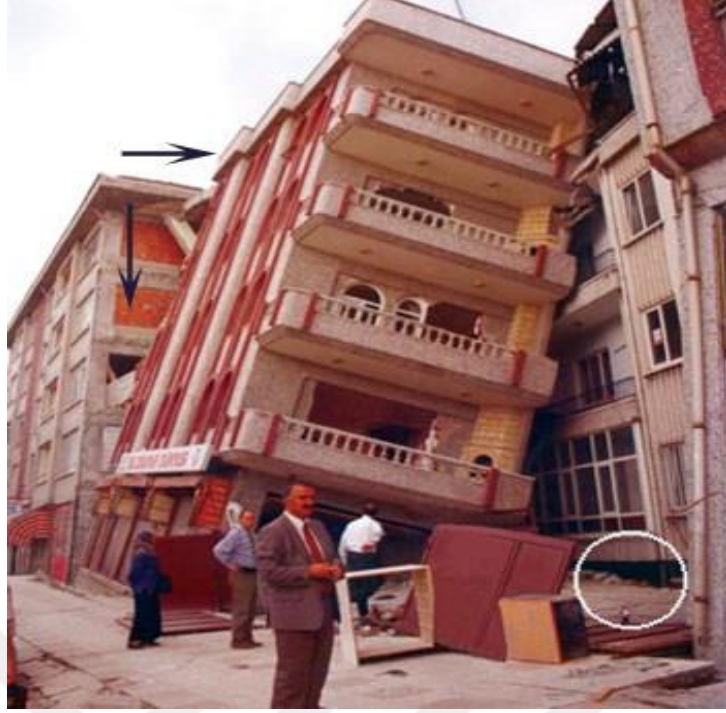
Şekil 5.11. Dar Cepheli Bir Binanın Devrilmiş Hali
