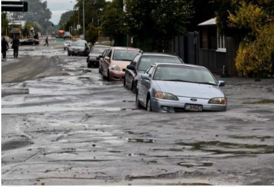
Şekil 5.16. Depremde Sıvılaştan Zeminden Yukarı Çıkan Su
