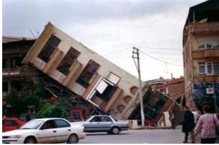
Şekil 5.5. B=4,00 Metre, H=16,00 Metre Olan Binanın Devrilmiş Hali-1
