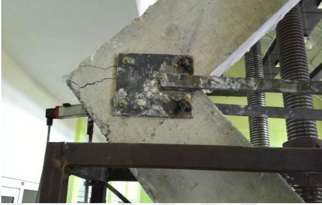
Şekil 3.29. Ankrajlama bölgesinde oluşan hasar
