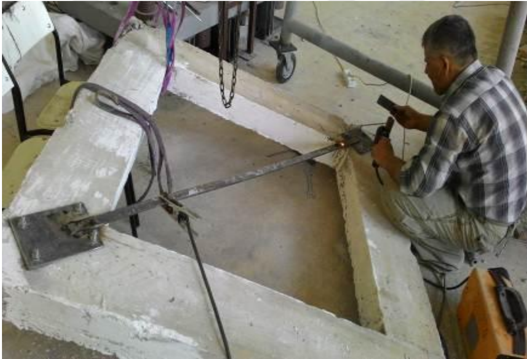
Şekil 2.10. Çelik Lamanın Kaynak Yapılması
