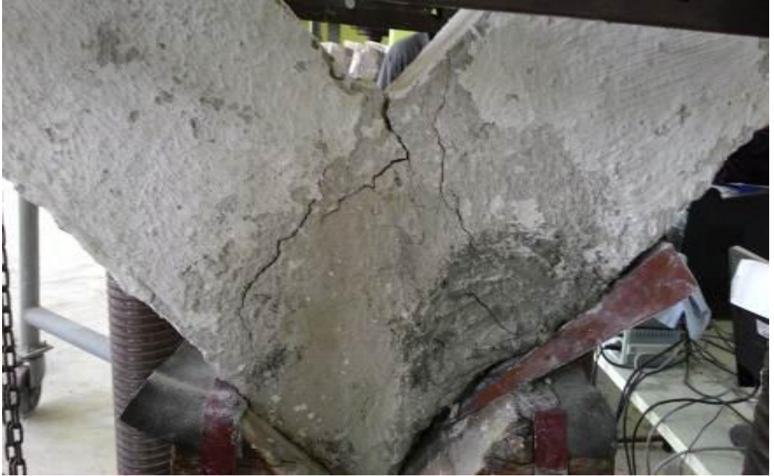
Şekil 3.32. Göçme anında oluşan hasar
