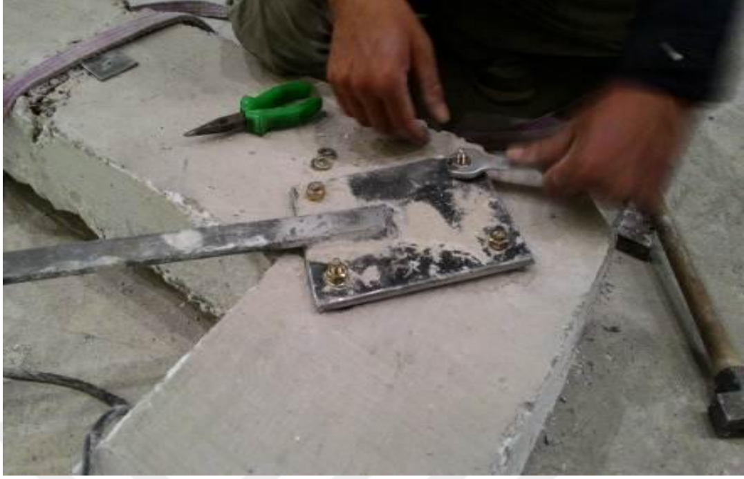
Şekil 2.9. Çelik Dübellerin Montajı
