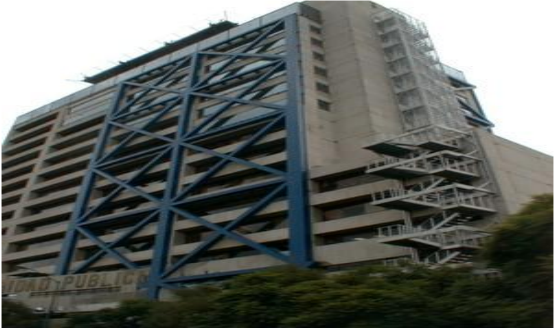
Şekil 1.13. Çelik Profillerle Güçlendirilmiş Bina Örneği
