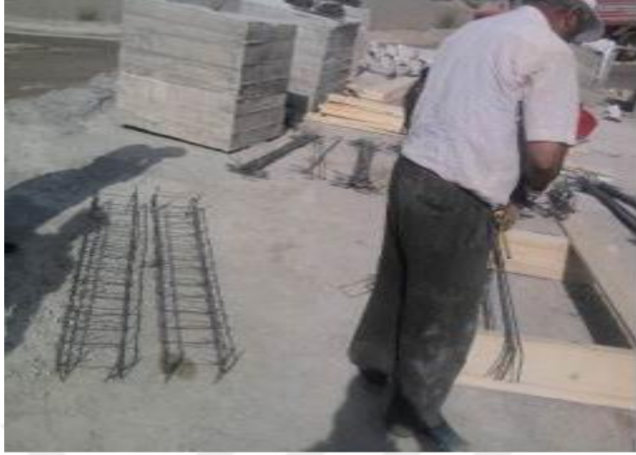
Şekil 2.3. Donatı Montajı
