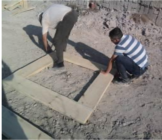
Şekil 2.2. Kalıp Montajı
