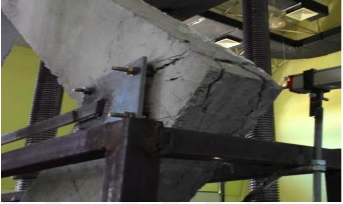
Şekil 3.14. Maksimum yükleme sonrası güçlendirme bölgesinde çerçeve ve ankraj dübellerinde meydana gelen hasar
