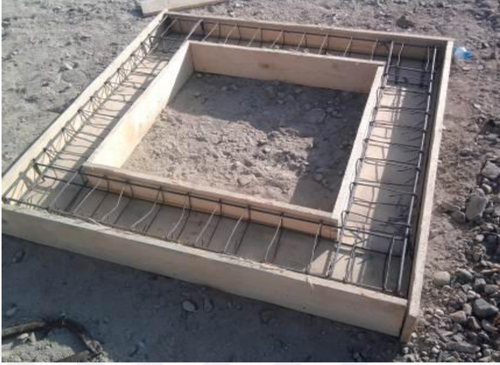
Şekil 2.5. Zayıf etriyeli numuneler (B1, B2, B3)
