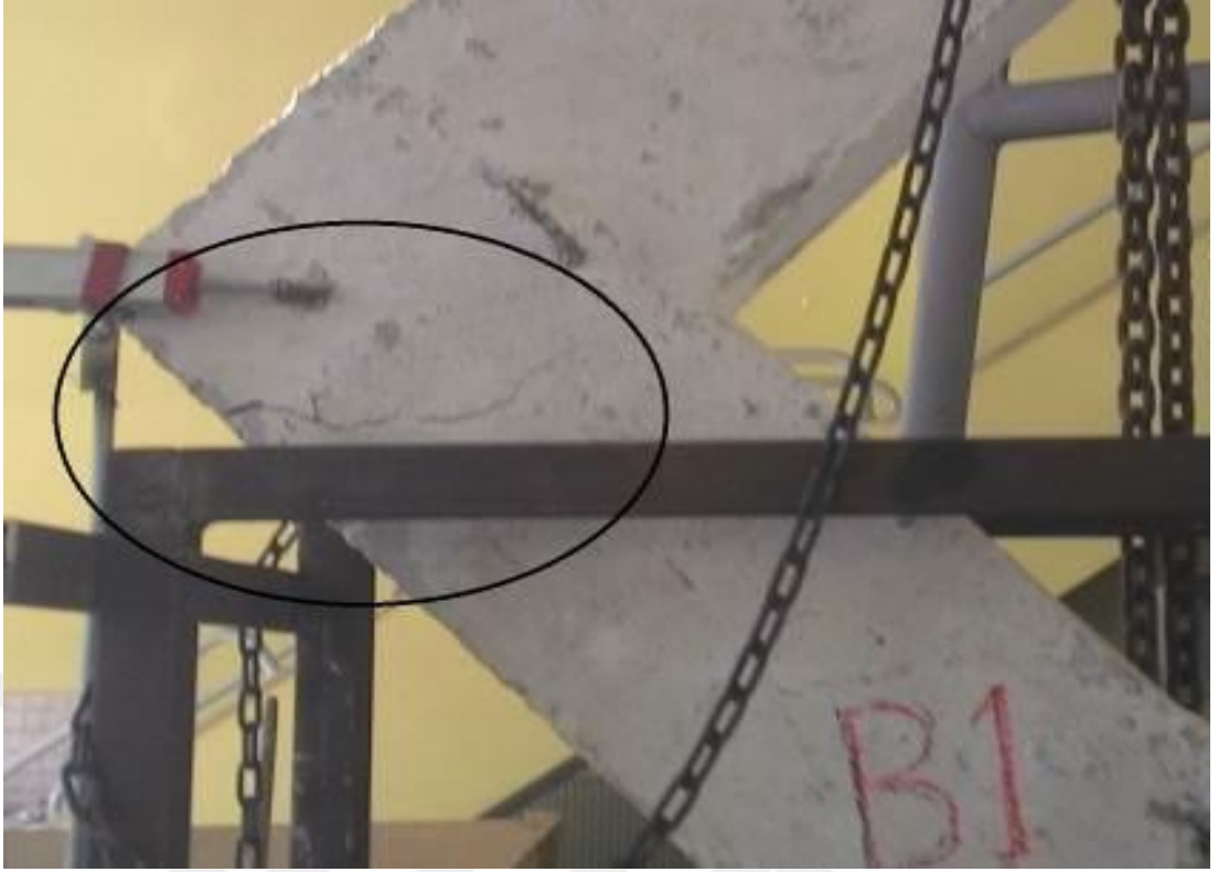
Şekil 3.4. Göçme anında oluşan çatlaklar
