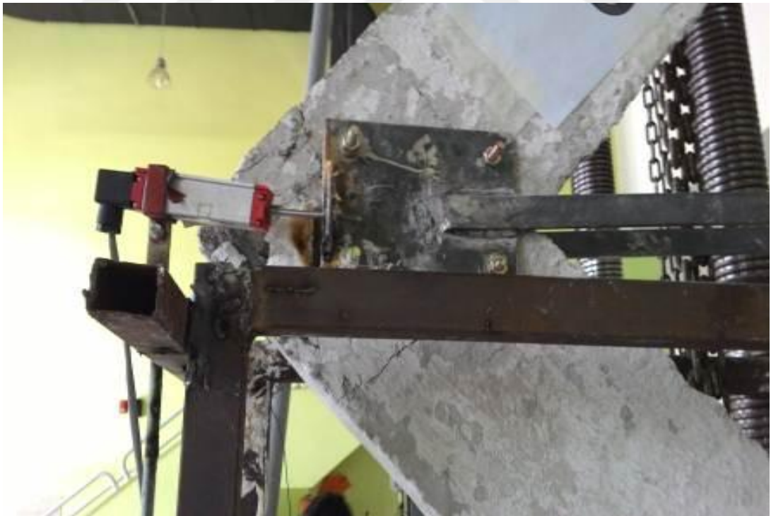
Şekil 3.30. Birleşim Bölgesinde Oluşan Hasar
