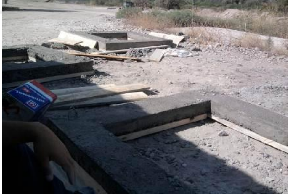
Şekil 2.6. Kalıpların sökülmesi
