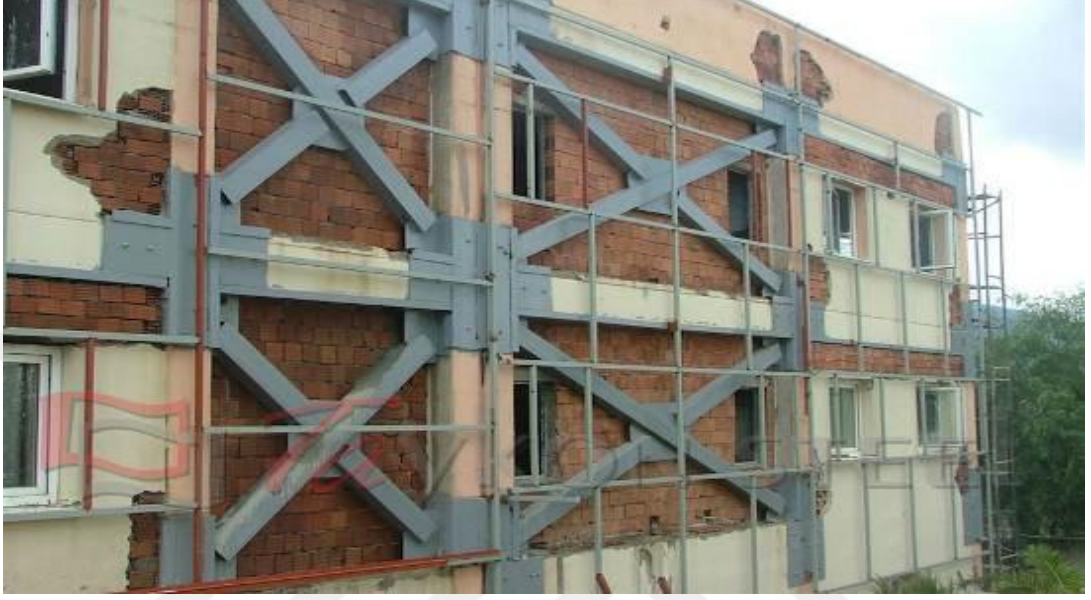
Şekil 1.12. Çelik Profillerle Güçlendirilmiş Bina Örneği
