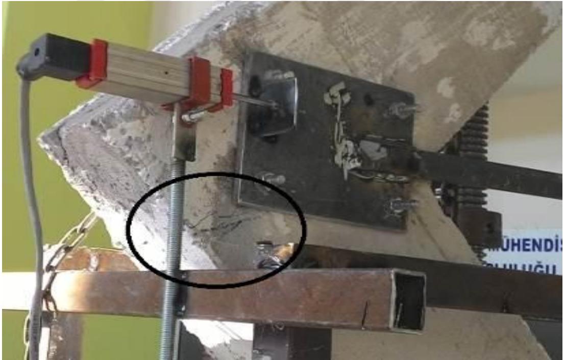
Şekil 3.8. 90 kN yükte oluşan çatlaklar
