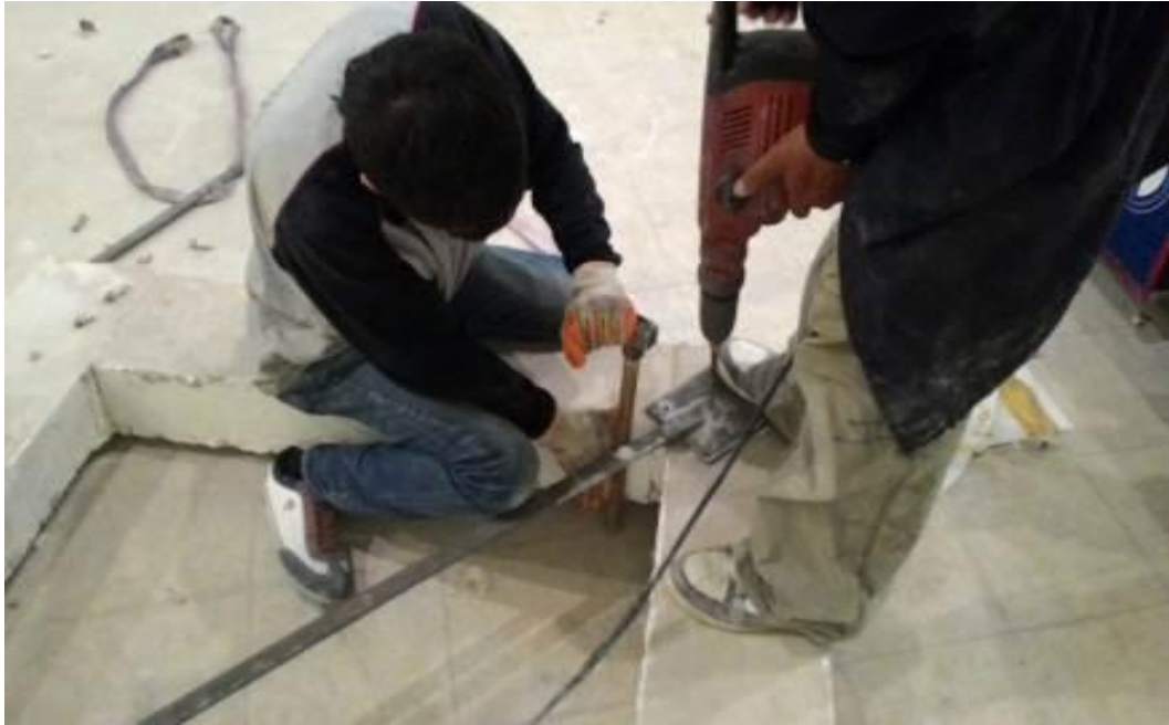
Şekil 2.8. Ankrāj Deliklerinin Açılması
