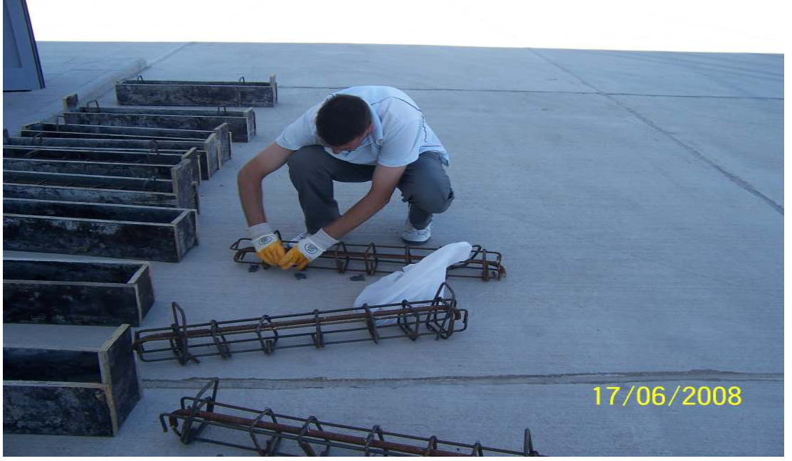
Şekil 2.8. Donatıların Kalıplara Yerleştirilmesi
