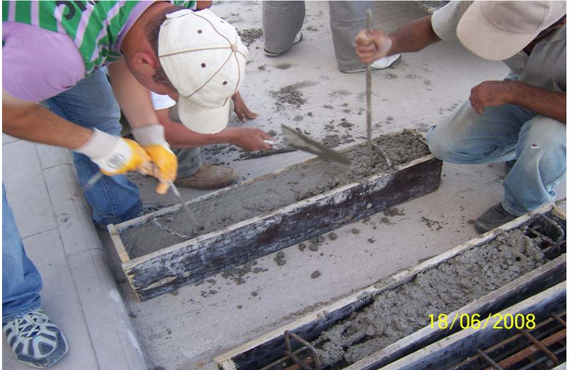
Şekil 2.11. Betonun Şişlenmesi
