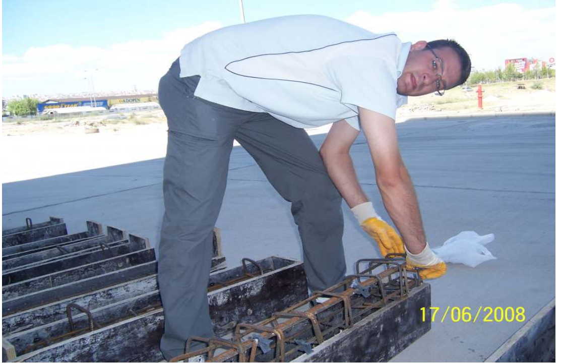
Şekil 2.9. Donatıların Kalıplara Yerleştirilmesi
