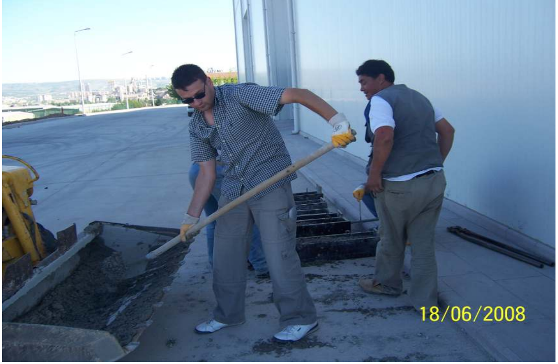
Şekil 2.10. Kalıplara Betonun Dökülmesi
