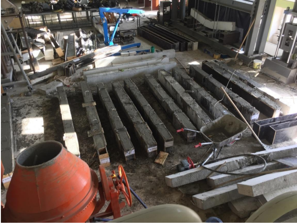
Şekil 2.7. Yüksek Dayanımlı Kirişlerin Beton Dökümü Sonrası Görüntüleri
