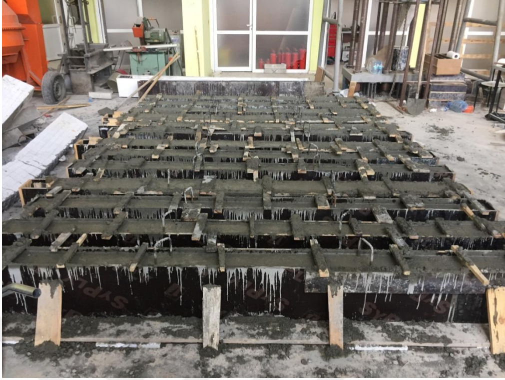
Şekil 2.8. Normal Dayanımlı Kirişlerin Beton Dökümü Sonrası Görünüşleri
