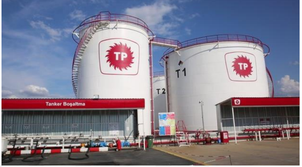
Şekil 5.2 Baz yağ ve akaryakıt depolama tankları görseli
