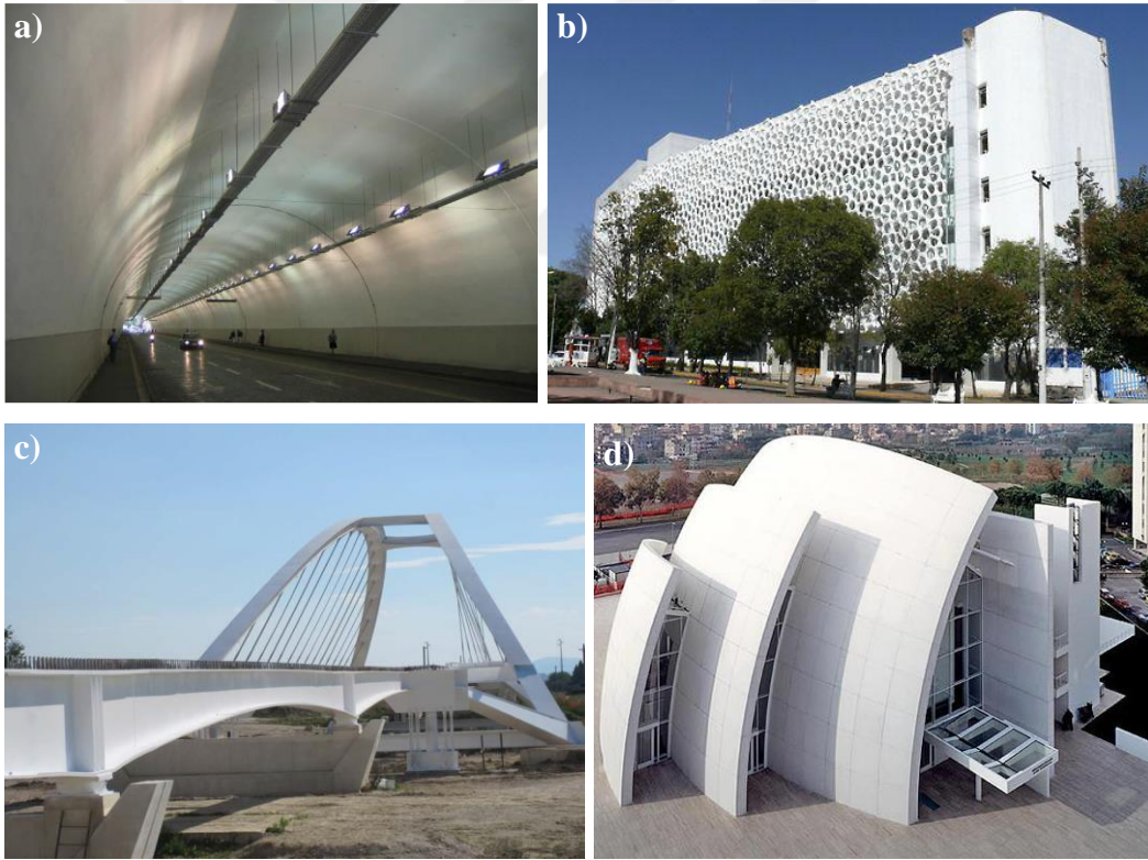
Şekil 2.6 Fotokatalitik etkiye sahip çimento bağlayıcı kompozit kullanılarak üretilen a) tüneller (De Marco vd., 2013), b) hastane (Topçu vd., 2020), c) köprü (De Marco vd., 2013) ve d) kilise (Cassar vd., 2003) yapıları
