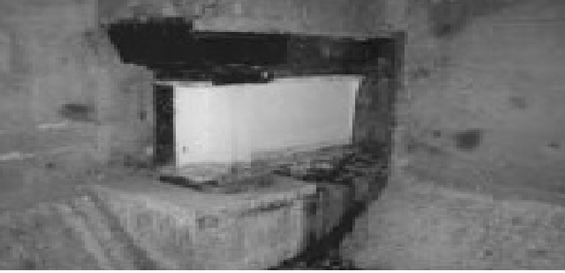
Şekil 4. Orta açıklık genişleme derzindeki mafsal düzeneği
