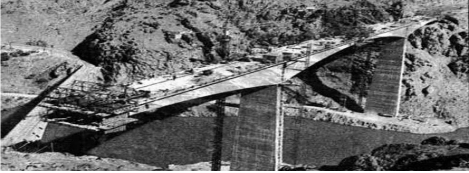
Şekil 2. Kömürhan Köprüsü'nün dengeli konsol yöntemi ile yapımı
